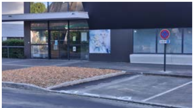
Les travaux de sécurisation du passage piétons devant Espace Évasion Bernard Douard se sont terminés fin juin.
