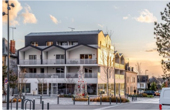
LE TRAVAIL SUR LA TOITURE
